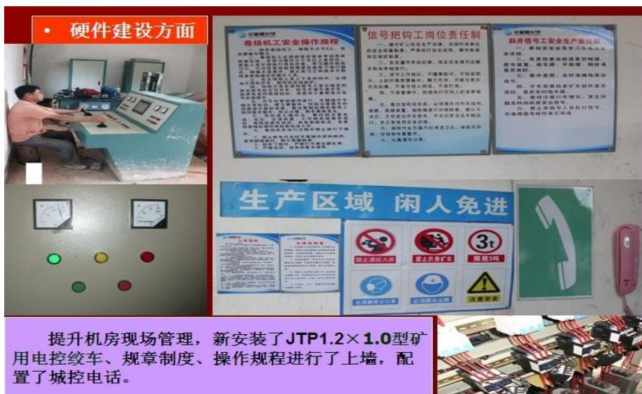
提升机房现场管理，新安装了JTP1.2×1.0型矿用电控绞车、规章制度、操作规程进行了上墙，配置了城控电话。
